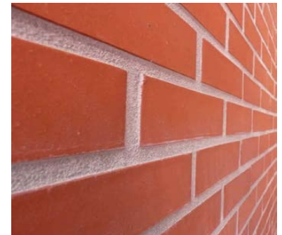
8. LIMPAR O EXCESSO DA ARGAMASSA DE REJUNTAMENTO COM ÁGUA LIMPA E UMA TALOCHA ESPONJA BEM ESPREMIADA UTILIZANDO UM BALDE COM ROLOS E LIMPANDO SEMPRE NA HORIZONTAL NO MESMO SENTIDO E MUDANDO DE ÁGUA COM FREQUÊNCIA ATÉ DEIXAR A SUPERFÍCIE COMPLETAMENTE LIMPA.
