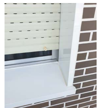
8. LIMPAR O EXCESSO DA ARGAMASSA DE REJUNTAMENTO COM ÁGUA LIMPA E UMA TALOCHA ESPONJA BEM ESPREMIADA UTILIZANDO UM BALDE COM ROLOS E LIMPANDO SEMPRE NA HORIZONTAL NO MESMO SENTIDO E MUDANDO DE ÁGUA COM FREQUÊNCIA ATÉ DEIXAR A SUPERFÍCIE COMPLETAMENTE LIMPA.
