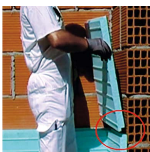
3. Aplicar correctamente as placas de XPS RESPEITANDO OS ENCAIXES MEIA MADEIRA.
