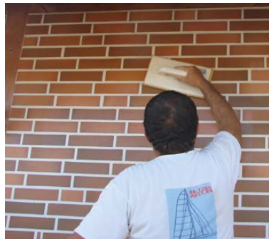
8. LIMPAR O EXCESSO DA ARGAMASSA DE REJUNTAMENTO COM ÁGUA LIMPA E UMA TALOCHA ESPONJA BEM ESPREMIADA UTILIZANDO UM BALDE COM ROLOS E LIMPANDO SEMPRE NA HORIZONTAL NO MESMO SENTIDO E MUDANDO DE ÁGUA COM FREQUÊNCIA ATÉ DEIXAR A SUPERFÍCIE COMPLETAMENTE LIMPA.
