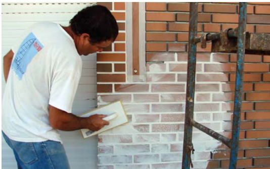
7. PREPARAR E APLICAR A ARGAMASSA DE REJUNTAMENTO CANDIWALL® ENCHENDO TOTALMENTE AS JUNTAS.
