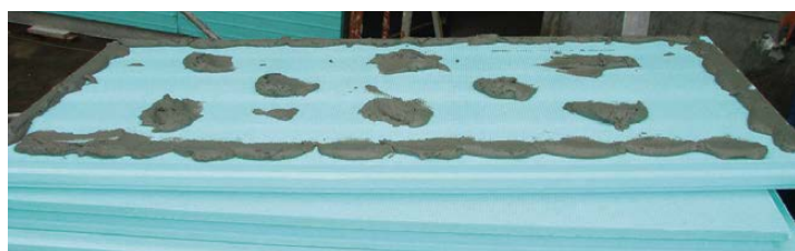
2. APLIQUE O ADESIVO NA PARTE POSTERIOR DAS PLACAS XPS (Colagem por pontos ou colagem total)
